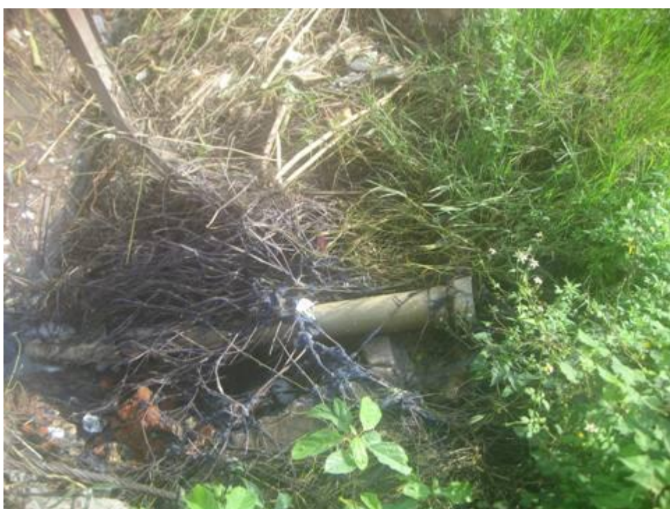
Toàn bộ nước thải bị công ty cho chảy thẳng xuống sông Đuống, bằng đường ống ngầm.
